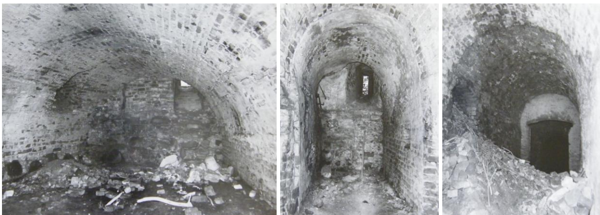
il. 61 Skrzydło zachodnie. Piwnice – pomieszczenie 01/3, korytarz 01/9 (oś pn-pd.) i (oś wsch-zach.). [poz.04]
