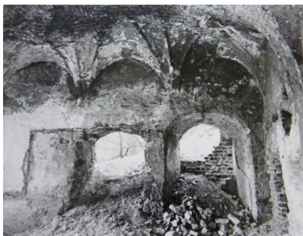
il. 70 Skrzydło zachodnie. Pomieszczenie 1/6 [poz.04]
