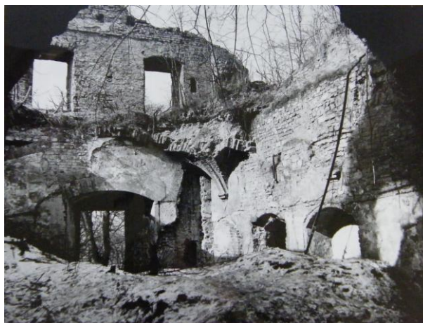
il. 71 Skrzydło zachodnie. Pomieszczenie 1/1. [poz.04]
