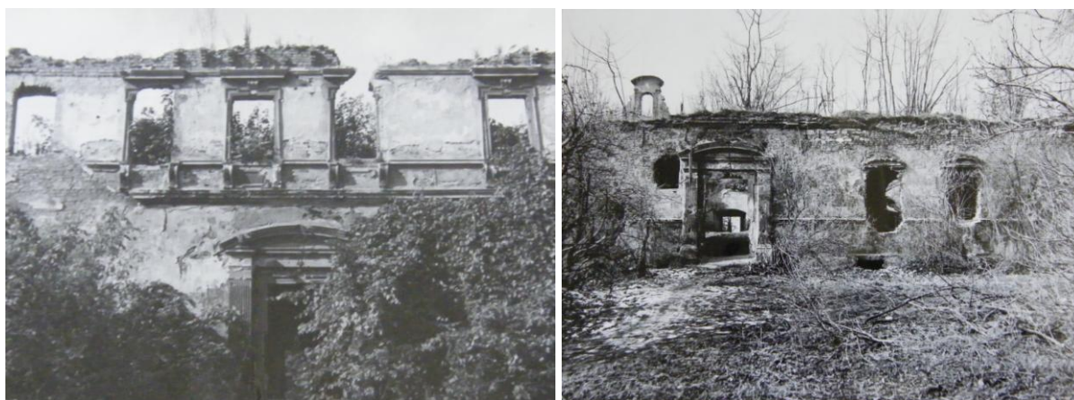
il. 43 Skrzydło zach. Elewacja wsch.(fot.1957r.) [poz.03] il. 44 Skrzydło zach. Elewacja wsch.(fot.1977r.) [poz.04]
