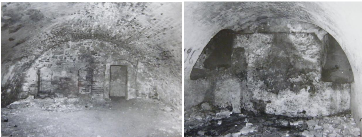
il. 63 Skrzydło zachodnie. Piwnice - pom. 01/1. [poz.04] il. 64 Skrzydło zachodnie. Piwnice - pom. 01/6. [poz.04]
